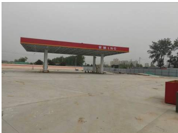
LNG 加气罩棚
