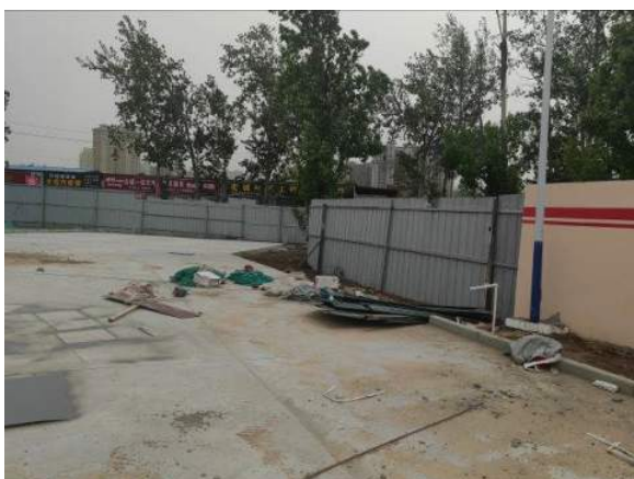
加气站入口连接处硬化区域
